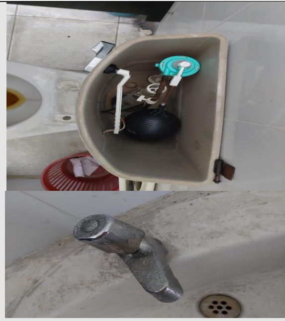
ítem 8.1 y 8.2 suministro e instalación de kit tanque sanitario y lavamanos.
