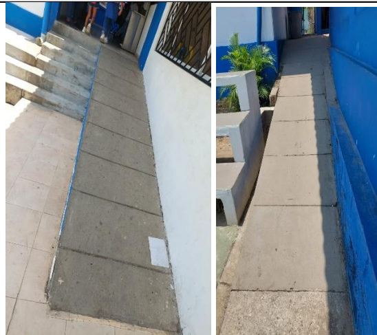
ítem 5.1 suministro e instalación de cinta antideslizante industrial en escalera
