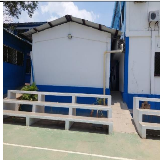
El ítem 10.2 construcción de gradería tipo
