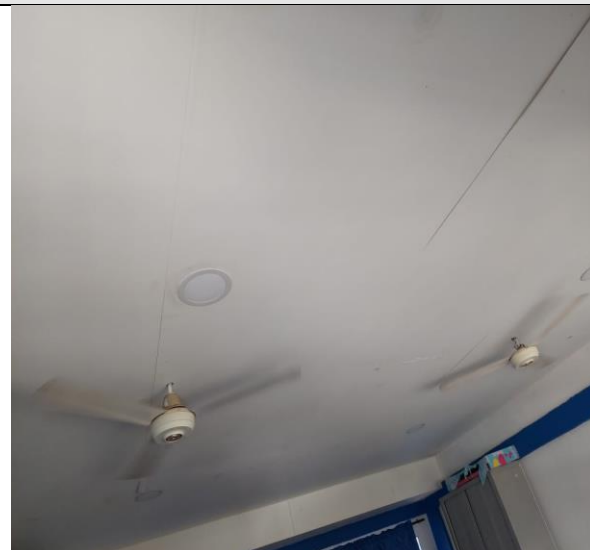
El ítem 3.4 Suministro e instalación de cielo raso en Drywall incluye acabado
